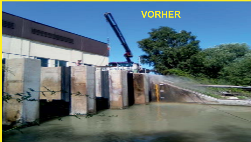
Wasserglas-Tiefenimprägnierung mit
