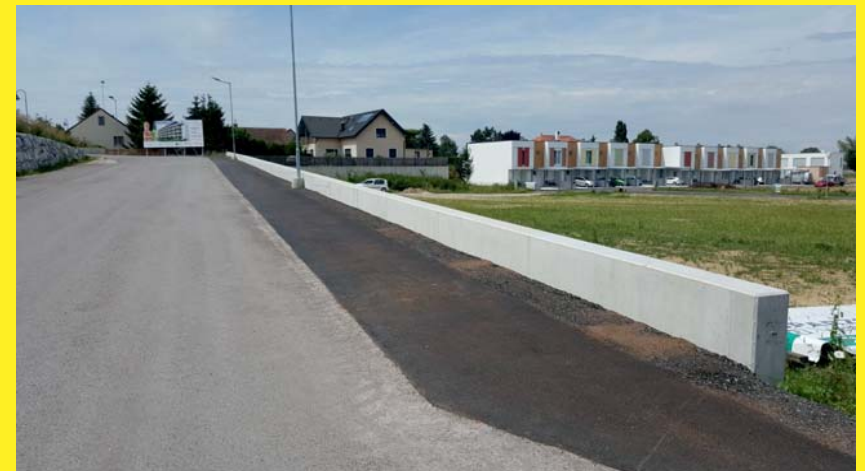
Beton-Stützmauer
